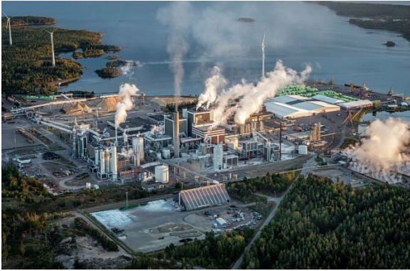
Figure 44. The Södra Kraft Pulp Mill at Mönsterås, Sweden.
